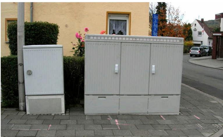
Die Standorte für die DSLAM-Verteilerkästen, die für den DSL-Ausbau notwendig sind wurden von der Telekom in Absprache mit der Gemeinde bereits festgelegt. Die Kästen sind 2m breit und 1,60m hoch, ähnlich wie auf dem Bild zu sehen. In den nächsten Wochen werden Erdarbeiten ausgeführt und danach die Verteilerkästen gesetzt. Der Starttermin Herbst 2010 für die Vollversorgung mit DSL gilt nach wie vor.
